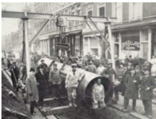
Figuur 1.2: De aanleg van een waterleiding in Groningen, 1882
